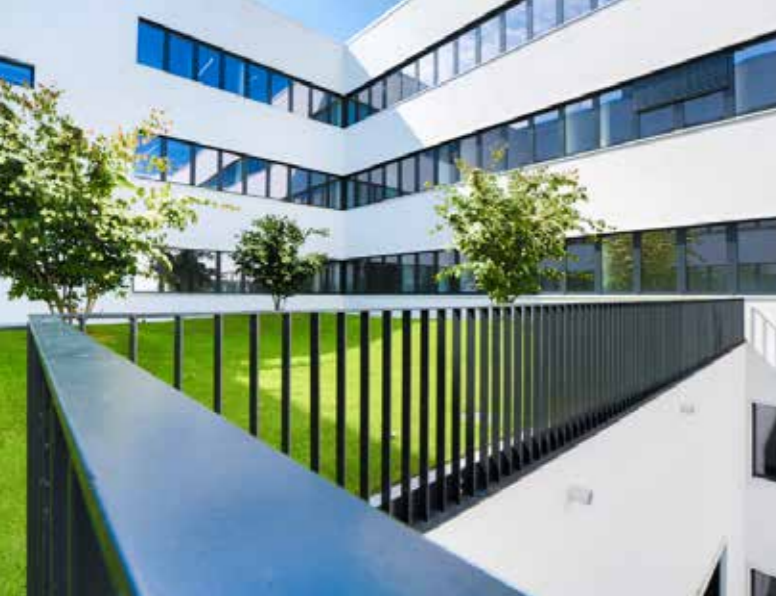
Bergische Universität, Gebäude V + W (Maschinenbau, Sicherheitstechnik, Chemie und Biologie) © Sebastian Jarych
